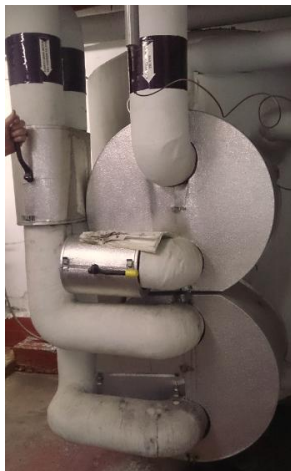
Varmtvandsbeholder med dobbeltspiral Teknisk økonomisk levetid 25 år
