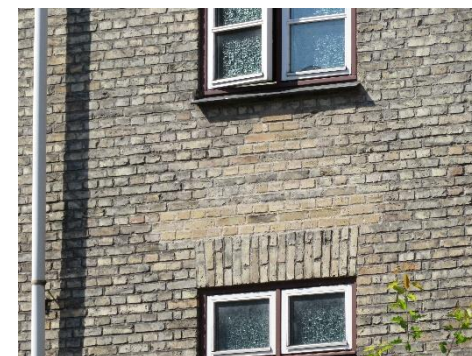
Stålprofil indlagt over muret stik
