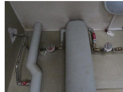
Vandrør på bagtrappe
