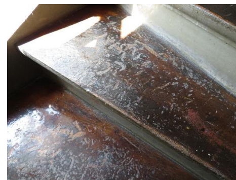
Trin på køkkentrappe
