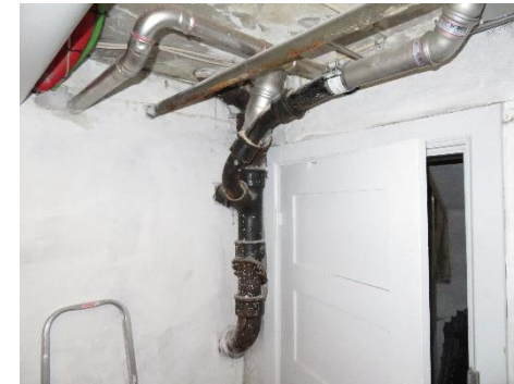
Faldstammer i kælder
