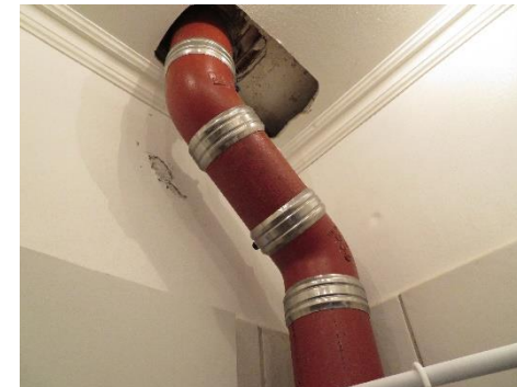
Udskiftet faldstamme i støbejern
