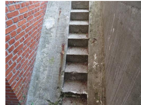
Udvendig kælder- trappe
